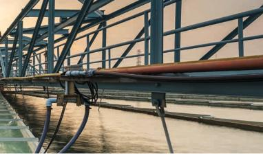
genutzt werden. Der verbleibende Elektroenergieverbrauch ist mit 0,2 kWh/m $^3$  O $_2$  niedrig. Da die erforderliche Sauerstoffmenge deutlich geringer als die benötigte Luftmenge ist, kann dadurch der gesamte Stromverbrauch um mehr als 60 % gesenkt werden.
