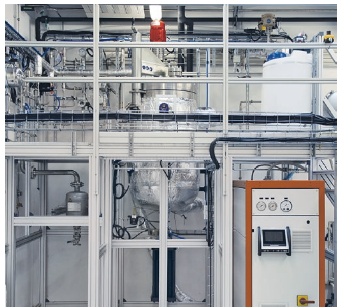
Bild 1: Autoklavenanlage am Fraunhofer-Technologiezentrum Hochleistungsmaterialien THM in Freiberg.
